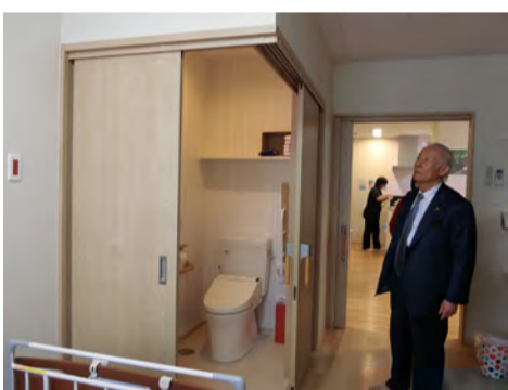
車椅子でも使えるように 二方向に扉が開く居室内のトイレ
