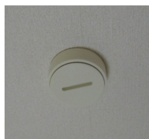
天井に取り付けられたオゾン脱臭装置
