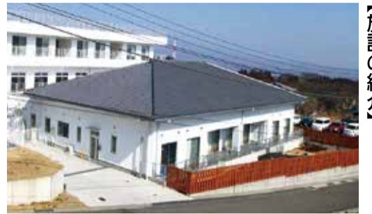
手前の平屋建てが新館（2ユニット）
