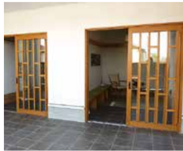
新館ユニットの玄関
