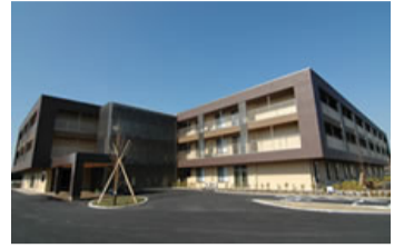
「eco&nature」をコンセプトに建てられた施設
